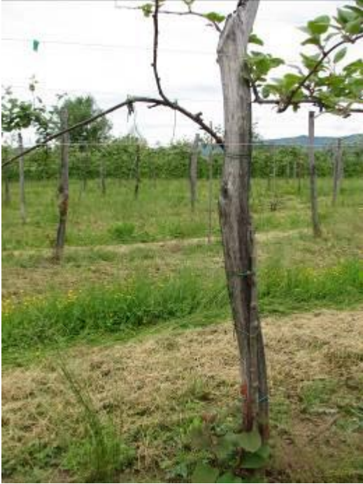
Slika 11: Uničen nadzemni del in začetek odganjanja iz podzemnega dela
