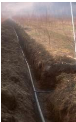
Slika 31: Izgradnja stabilnega oroševalnega sistema.
